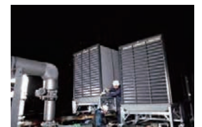
冷却塔更新工事
