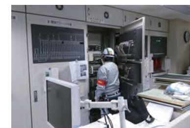
中央監視設備更新工事
