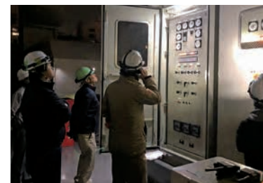
受変電設備更新工事
