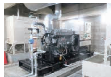
非常用自家発電機更新工事
