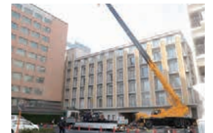
重量機器の搬入作業
