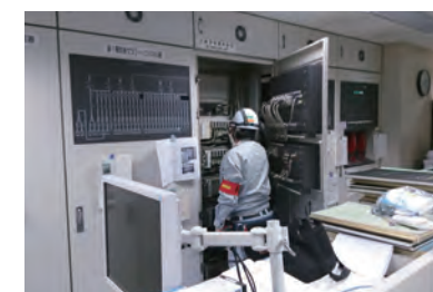
中央監視設備更新工事
