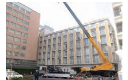
重量機器の搬入作業
