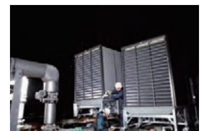
冷却塔更新工事
