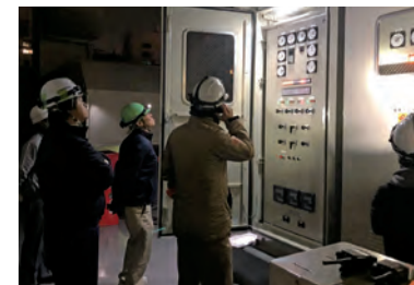
受変電設備更新工事
