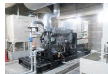
非常用自家発電機更新工事
